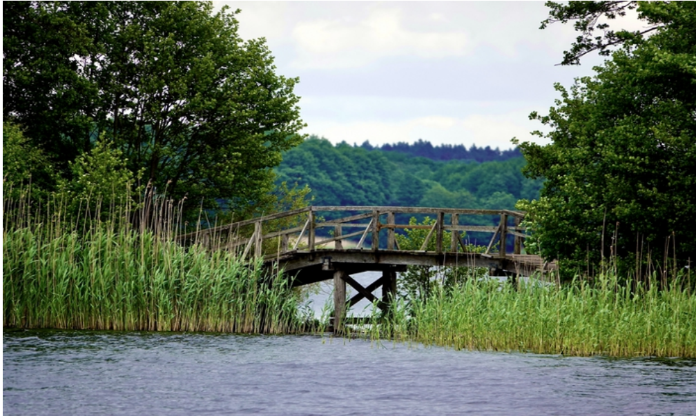
F: Über einen künstlich aufgeschütteten Damm und eine Brücke führt der Wanderweg auf den „Strangen“.
